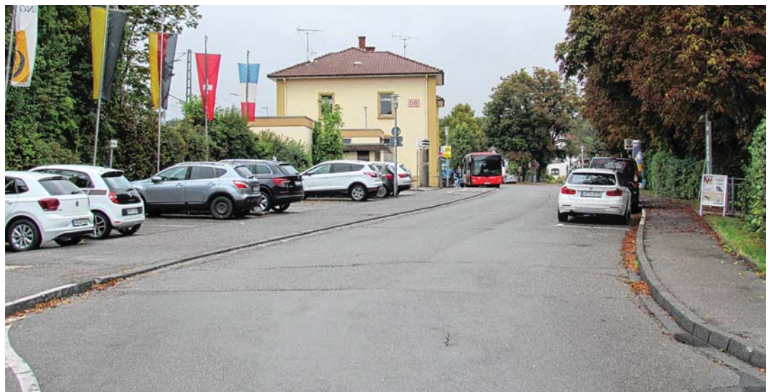
Mit dem Beschluss der entsprechenden Satzung kann es losgehen mit der Stadtsanierung »Bahnhofsbereich mit Altstadt« und damit mit der Planung für eine Umgestaltung des Bereiches um den Bahnhof Engen samt Bahnhofsbauwerke. Bild: Hering
